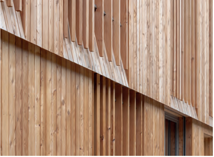
De lariks lamellen zijn aan de onderzijde afgeschuind.
